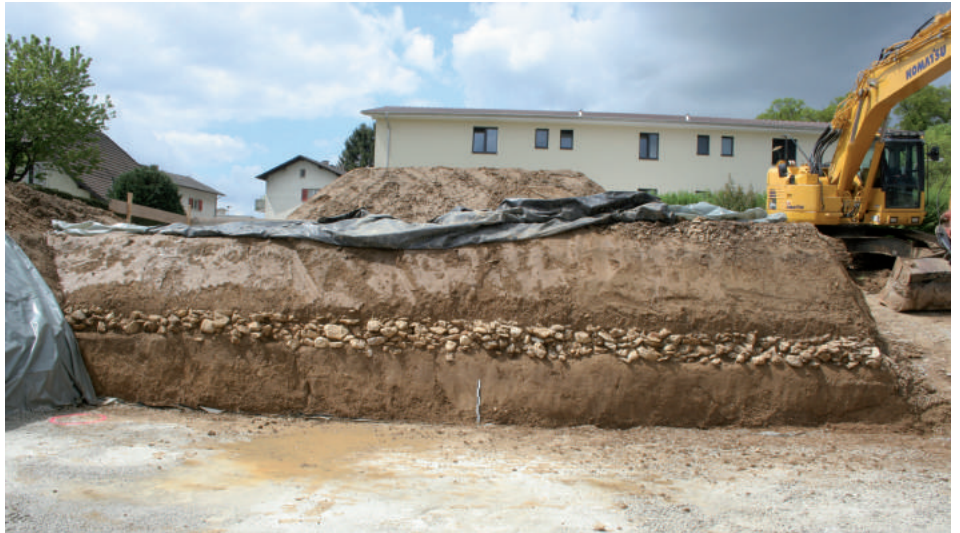
La bordure de la route apparaît nettement dans la tranchée. Photo: www.jura.ch / OCC-SAP.
