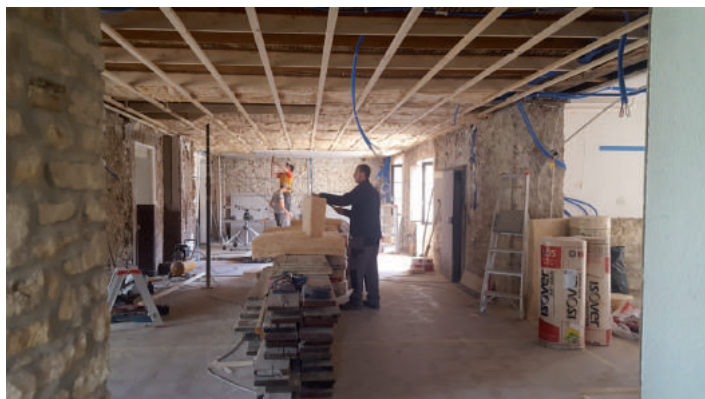
Pose d'isolation et réfection du plafond. Photo: Drilon Loshi / Alan Stalder.
