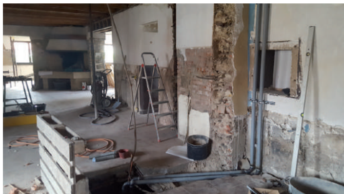
Aménagement de tuyaux pour les futures rénovations au deuxième étage. Photo: Drilon Loshi / Alan Stalder.
