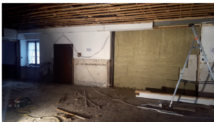
L'ancien salon transformé en secrétariat et couloir d'accueil. Photo: Drilon Loshi / Alan Stalder.
