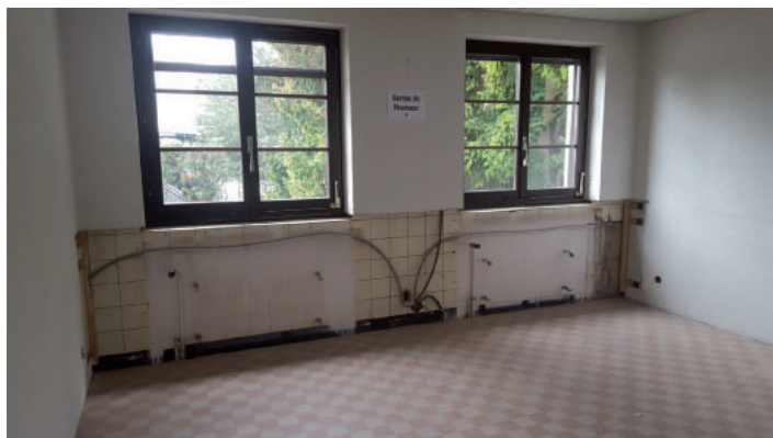
Bureau du secrétaire communal avec une rénovation totale. Photo: Drilon Loshi / Alan Stalder.
