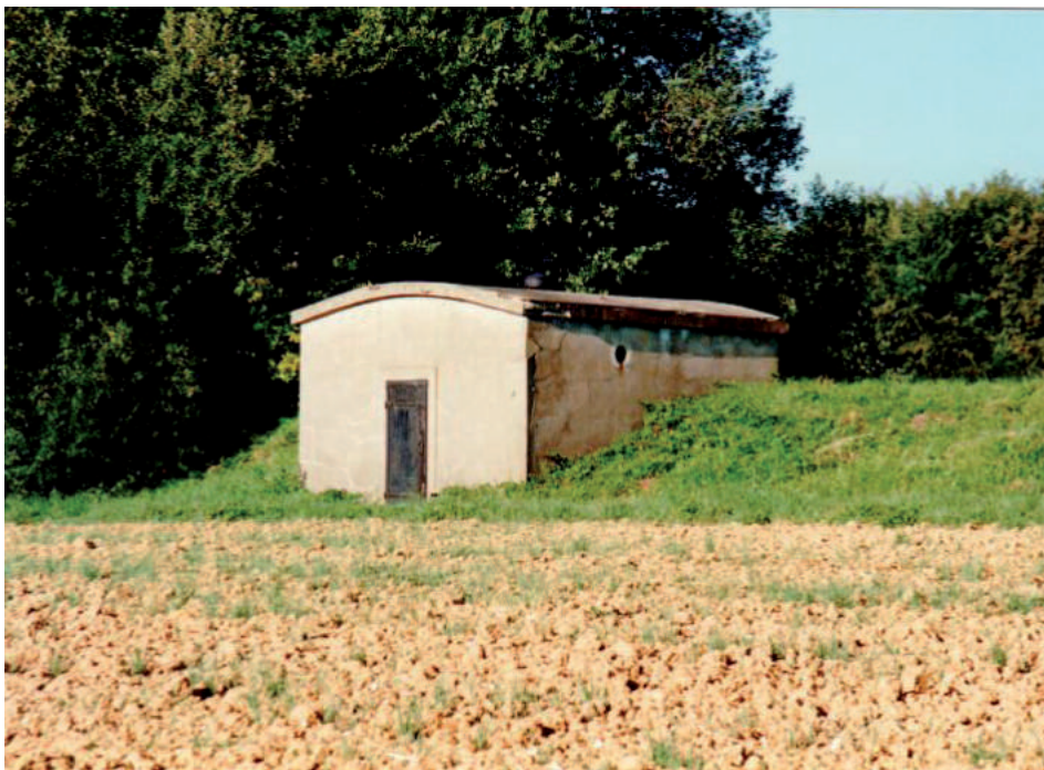
Le premier réservoir à l'Est du village. Source: Fondation du patrimoine.
