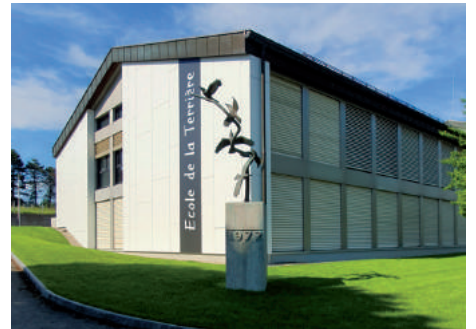
L'école de la Terrière récemment rénovée.
