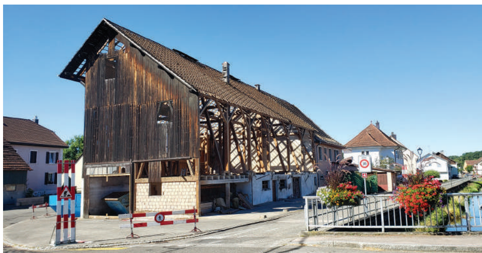
Sur la photo, les premiers éléments de la grange ont été démontés. Photo: Alan Stalder.
